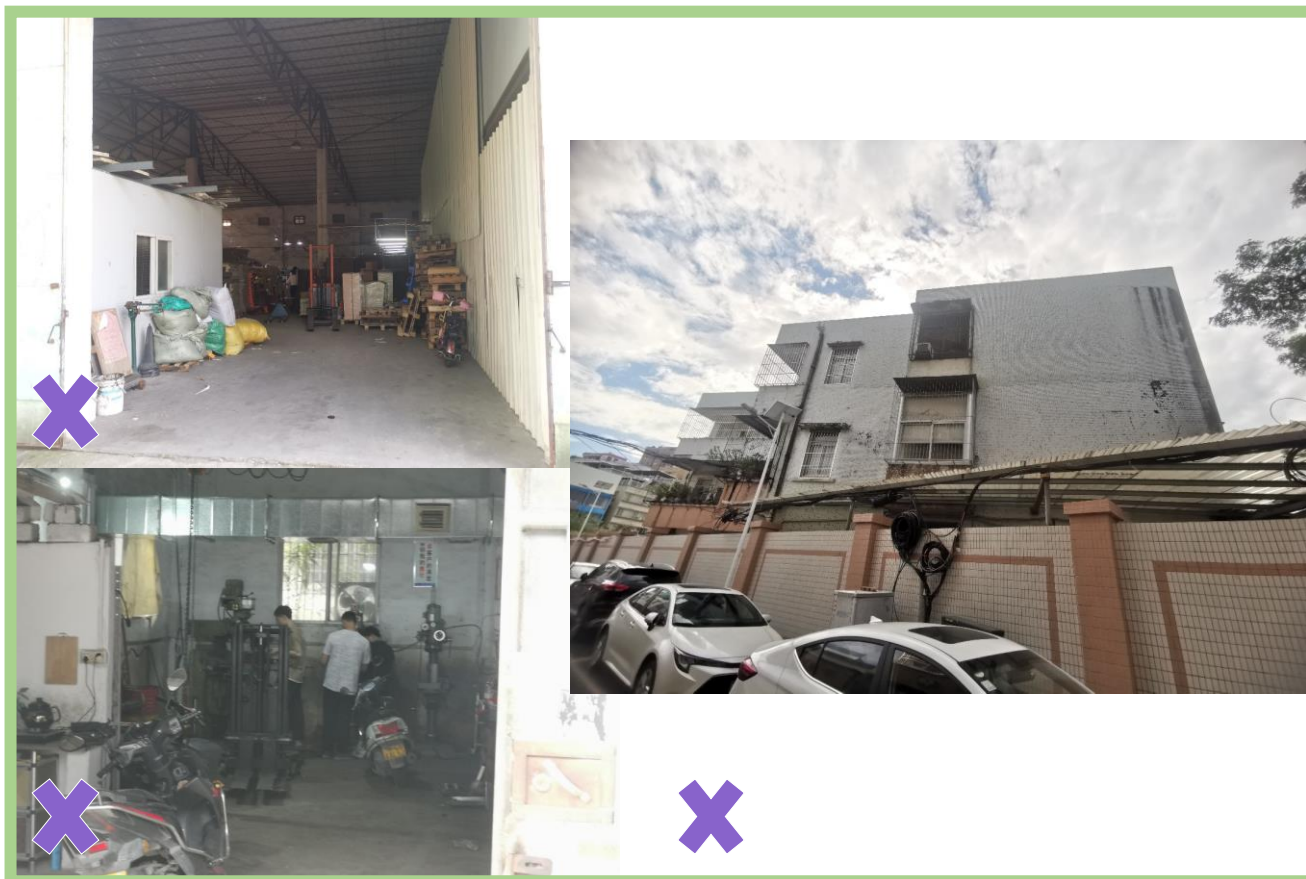
改造项目范围旧厂房建筑
